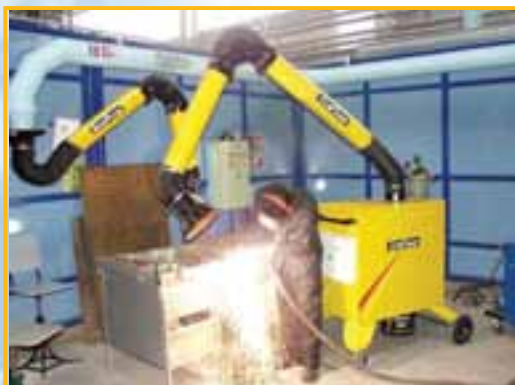
г. Электросталь. Завод "Элемаш". Сварочный участок. Передвижной фильтровентиляционный аппарат EMK.
