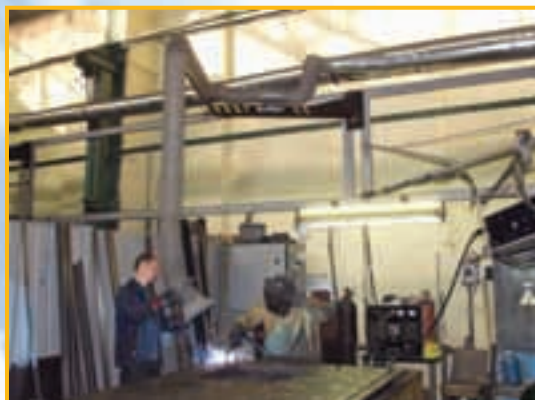
Санкт-Петербург. ТОО "Проём". Сварочный участок. Производство дверей. Консольно-поворотное вытяжное устройство УК.
