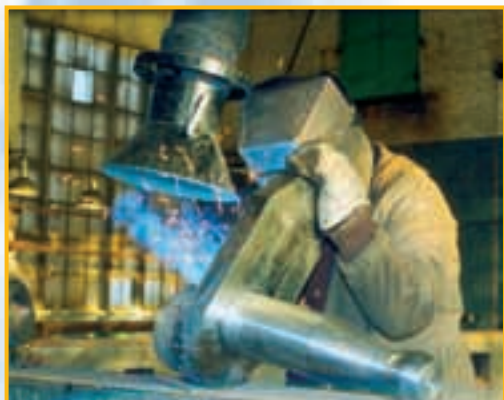
Алюминиевый завод (КАЗ). Цех нестандартного оборудования №1. Удаление сварочных дымов, непосредственно от источника выделения.
