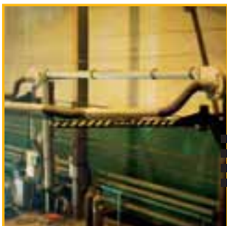
Подключение вытяжных устройств к вентилятору через переходник П250-160.
