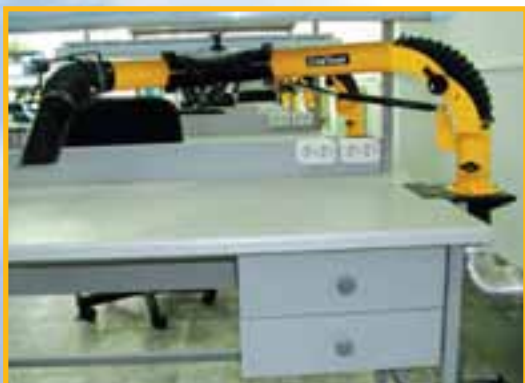
Воронеж. ООО "Александр Электрик Дон", Настольные вытяжные устройства "DELI-M", подключенные к системе центральной вентиляции.
