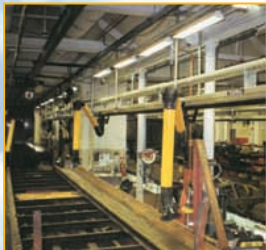
Вариант монтажа нескольких устройств KUA на одном рельсе-воздуховоде.
